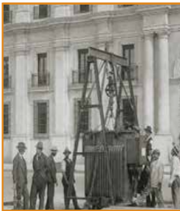
Transformador para el Barrio Cívico, instalado en 1930
